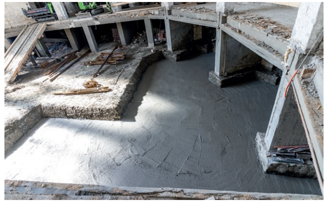
Der Boden des Kirchenschiffs ist entfernt und ein Teil des darunterliegenden Kriechkellers wird für Technikraum und zwei neue Archivräume vorbereitet.
