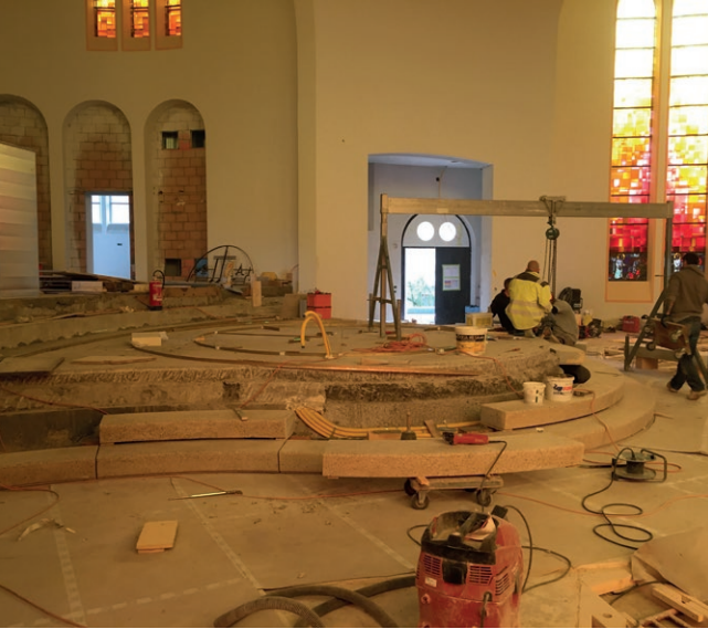
Die geschwungenen Stufen zum Altarraum werden versetzt.
