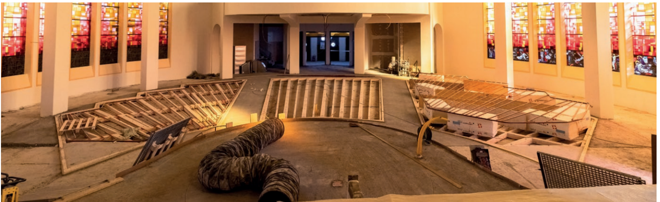
Vorbereitungen für die neue Fussbodenheizung.
