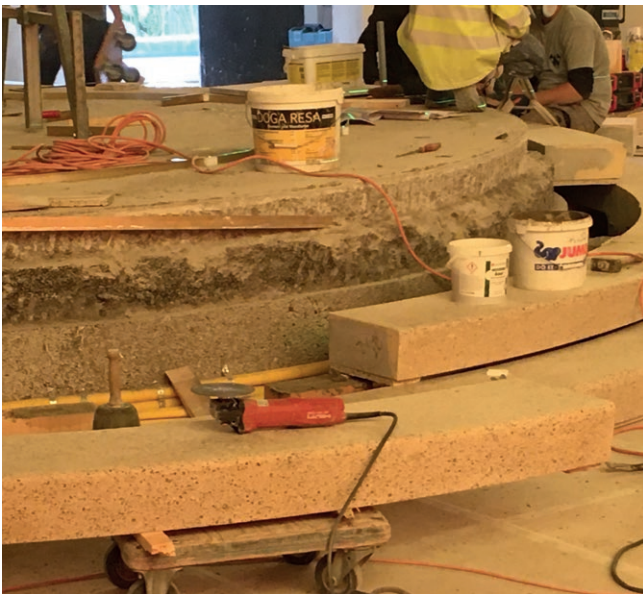
Die geschwungenen Stufen zum Altarraum werden versetzt.
