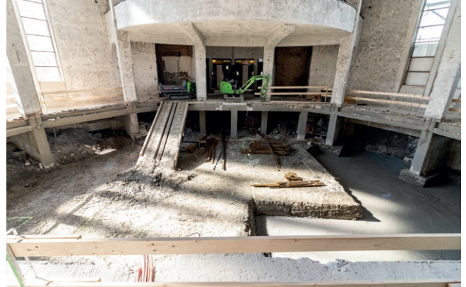
Der Boden des Kirchenschiffs ist entfernt und ein Teil des darunterliegenden Kriechkellers wird für Technikraum und zwei neue Archivräume vorbereitet.
