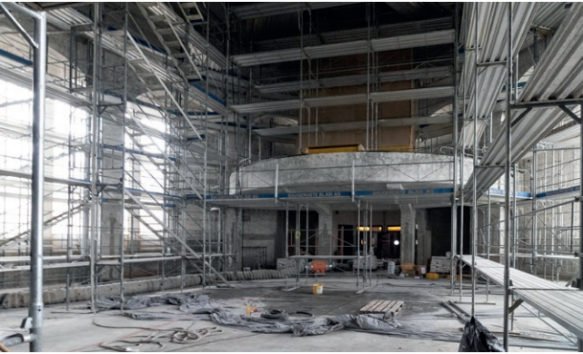
Der ganze Bereich der Kellerdecke wurde betoniert. Die ersten Gerüstarbeiten beginnen.
