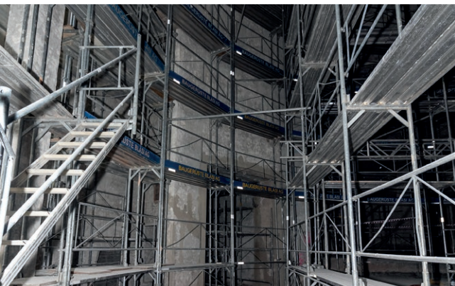
Der ganze Bereich der Kellerdecke wurde betoniert. Die ersten Gerüstarbeiten beginnen.
