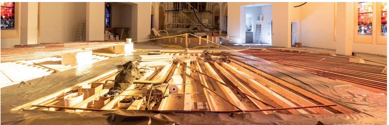
Vorbereitungen für die neue Fussbodenheizung.
